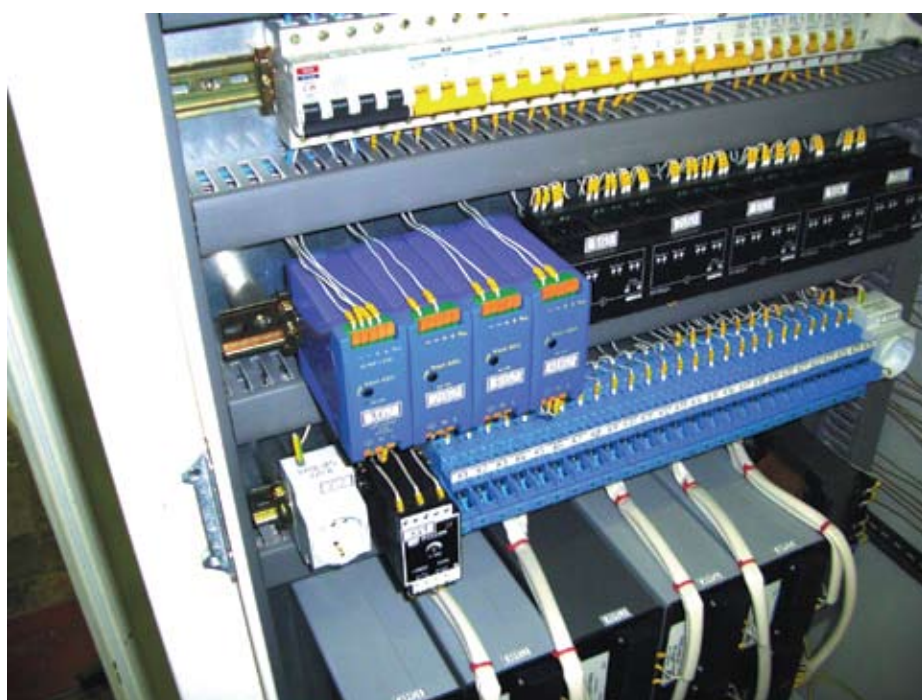
Рис. 3. Пример использования DRAN30 в шкафу промышленной автоматизации
